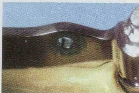
№132-11 отверстие в балке и область, прилегающую к отверстию на расстоянии 2...3 мм;
